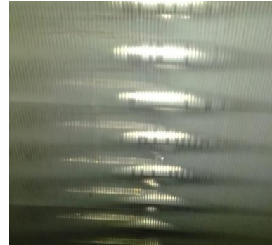
Serpentín de evaporadora durante el mantenimiento
