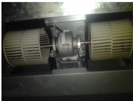
Motor ventilador de evaporadora durante el mantenimiento
