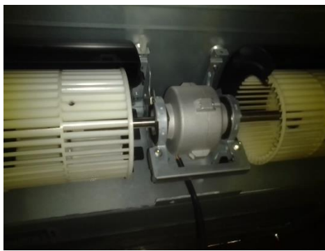
Motor ventilador después del mantenimiento
