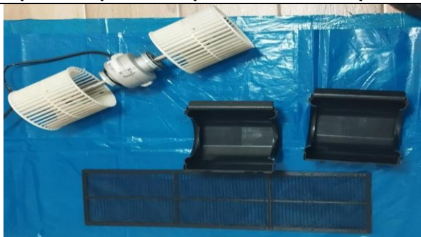
Accesorios de evaporadora durante el mantenimiento
