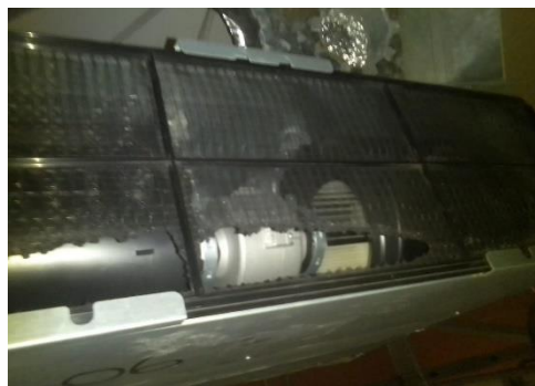
Unidad evaporadora antes del mantenimiento
