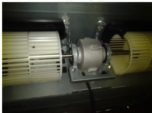
Motor ventilador de evaporadora después del mantenimiento
