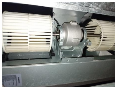
Motor ventilador después del mantenimiento
