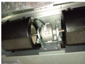
Motor ventilador después del mantenimiento
