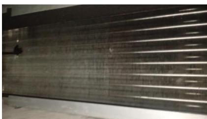
Serpentín de evaporadora durante el mantenimiento
