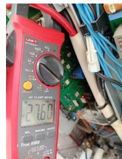
Medición de parámetros de corriente y presión después del mantenimiento
