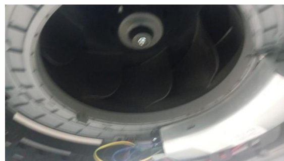
Motor ventilador de la unidad evaporadora
