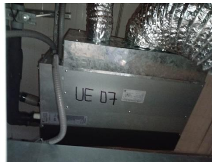
Unidad evaporadora después del mantenimiento
