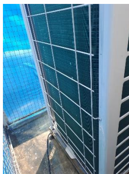
Serpentín de unidad condensadora después del mantenimiento
