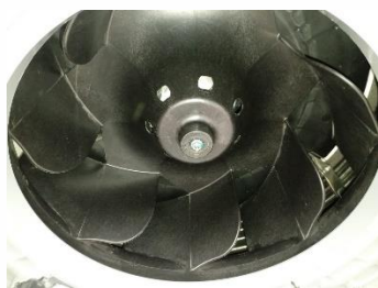
Motor ventilador de evaporadora después del mantenimiento
