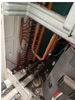
Unidad condensadora antes del mantenimiento
