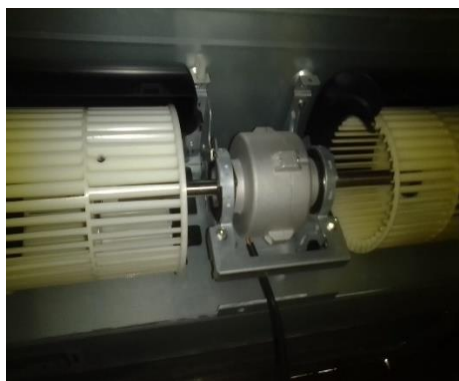
Motor ventilador después del mantenimiento
