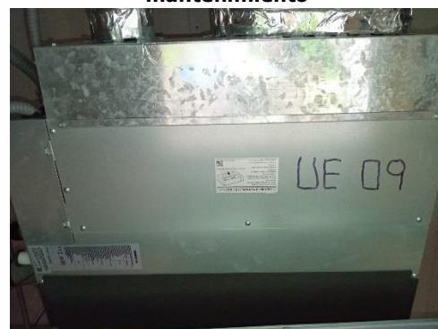
Unidad evaporadora después del mantenimiento
