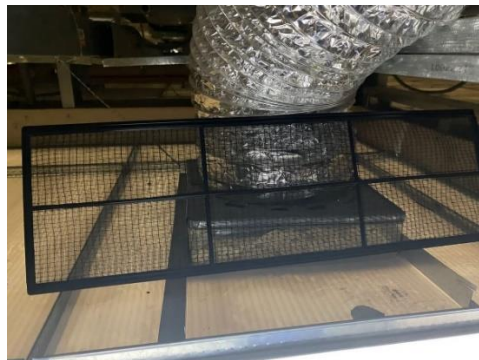
Filtro de evaporadora después del mantenimiento
