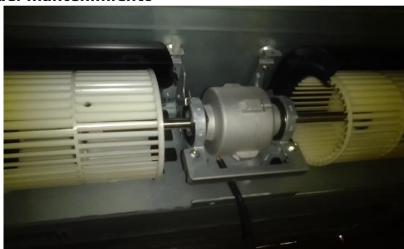
Motor ventilador de evaporadora después del mantenimiento
