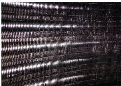
Serpentín de evaporadora después del mantenimiento
