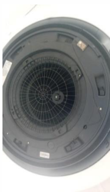
Motor ventilador de la unidad evaporadora
