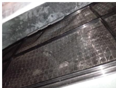
Filtro de evaporadora después del mantenimiento
