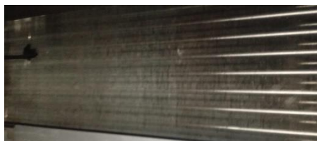
Serpentín de evaporadora después el mantenimiento
