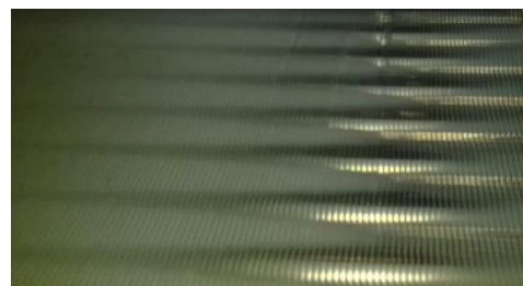
Serpentín de evaporadora después del mantenimiento
