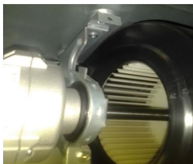
Motor de unidad evaporadora antes del mantenimiento
