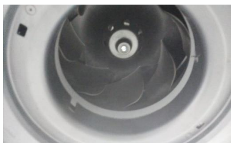
Motor ventilador de evaporadora durante el mantenimiento
