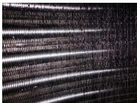
Serpentín de evaporadora durante el mantenimiento
